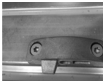
Рисунок 7. Соединения секций, установленные в середине нижнего и верхнего профилей
